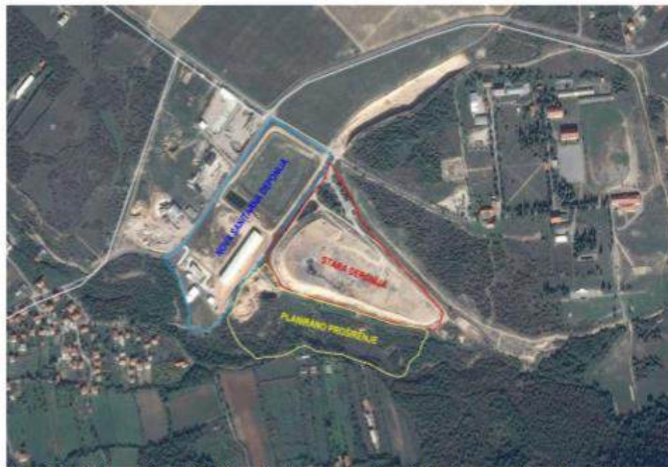
Slika 1.1. Satelitski pogled na područje deponije: stara zatvorena deponija Uborač, nova sanitarna deponija i buduće planirano proširenje deponijskog prostora na rezerviranoj površini
