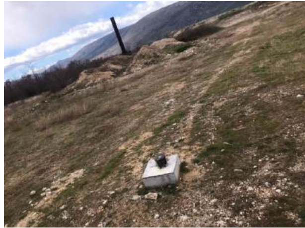
Slika 21. Novi piježometar na lokaciji iznad (istočno) stare deponije pored AB ograde
