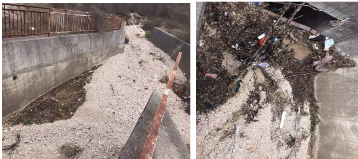
Slika 19. Stanje korita potoka Sušice - lokacija ulazne građevine
