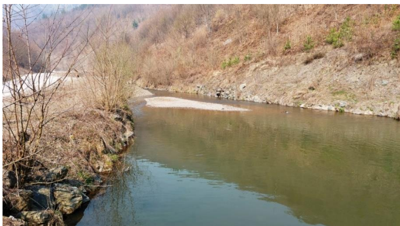
Slika 65. Sprud vučenog nanosa u maloj akumulaciji iza vodozahvata MHE na Bistričaku
