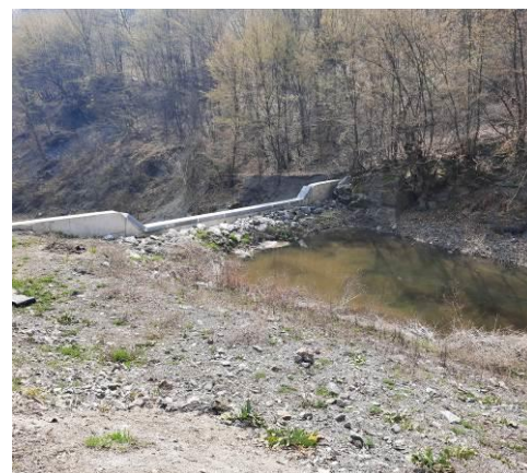
Slika 48. Erozioni proces u dijabaz-rožnoj formaciji (J), duž toka Starinskog potoka i formiranje pregrade za kontrolirano upravljanje stihijskim vučenim nanosom
