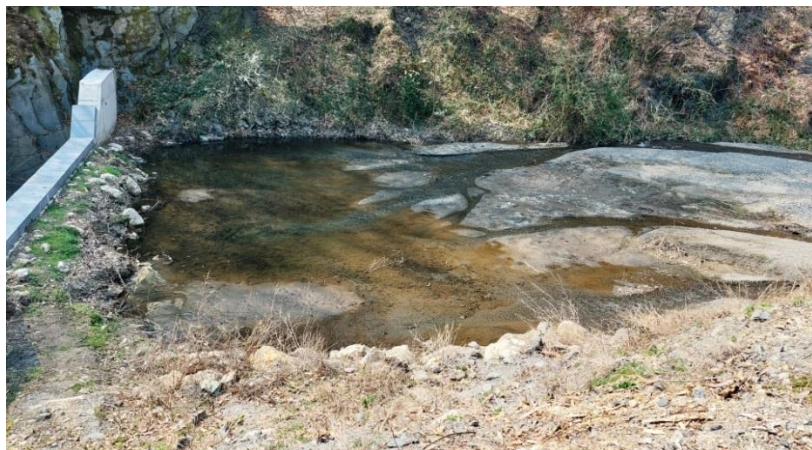
Slika 62. Akumulacija vučenog nanosa iza bujične pregrade u koritu Staračkog potoka
