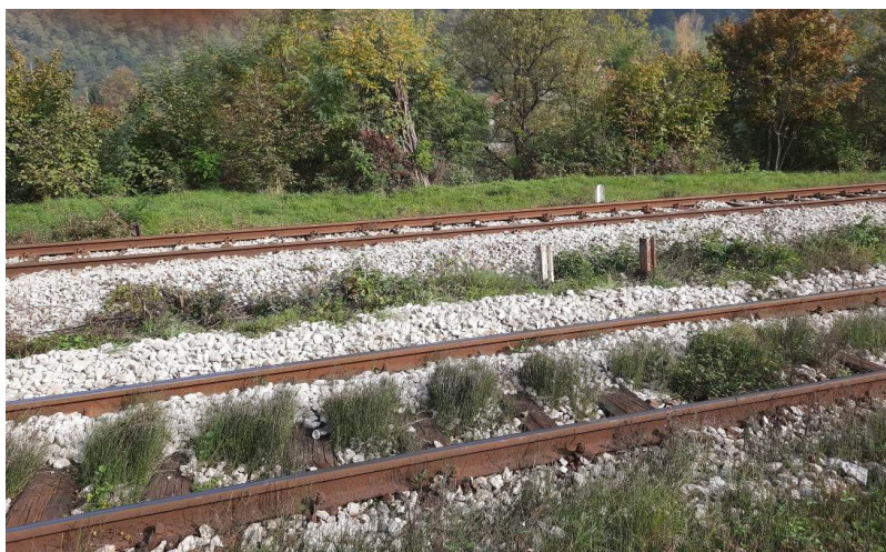
Slika 51. Detalj željezničke pruge prema rijeci Bosni u prostoru uslovno stabilnog terena
