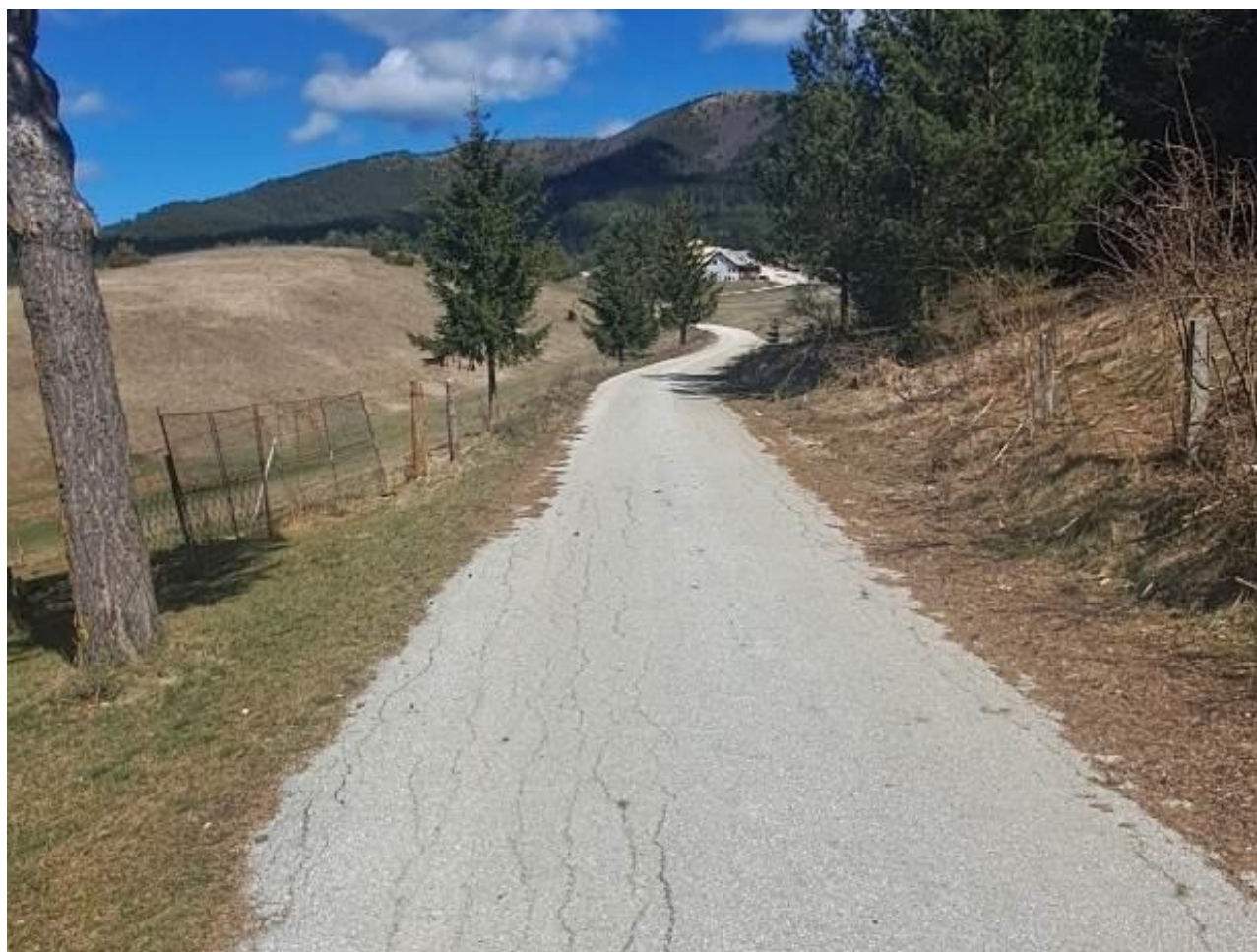
Slika 102 Postojeće stanje prometne infrastrukture na pristupnoj cesti
