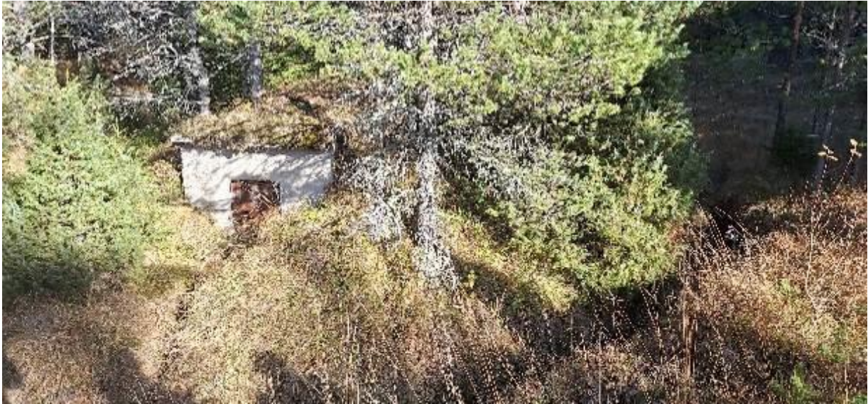
Slika 77 Izvor Ograđenica (Bili potok – otvoreni tok, kaptaža)
