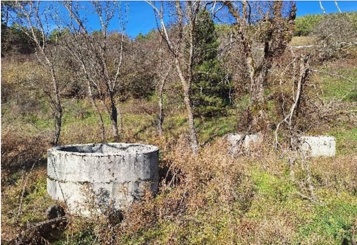
Slika 73 Izvor Olovo u istimenom zaseoku – općina Kupres (spremnici za vodu)
