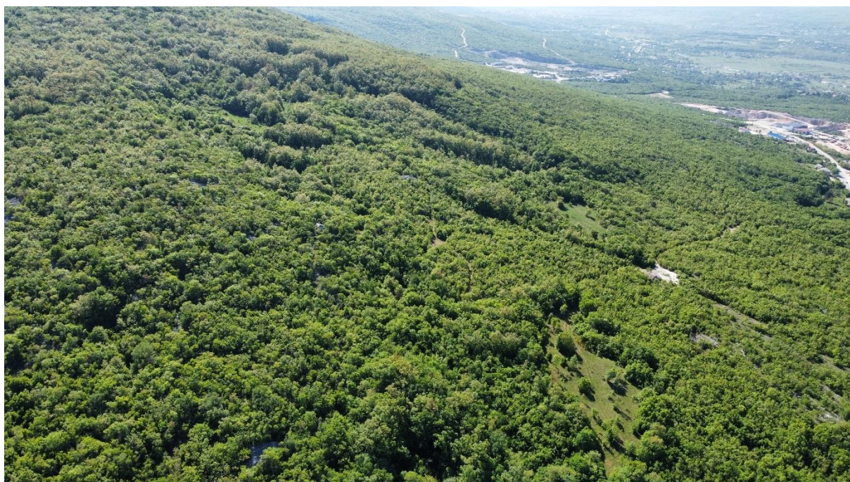
Slika 123 Pogled na zonu izgradnje
