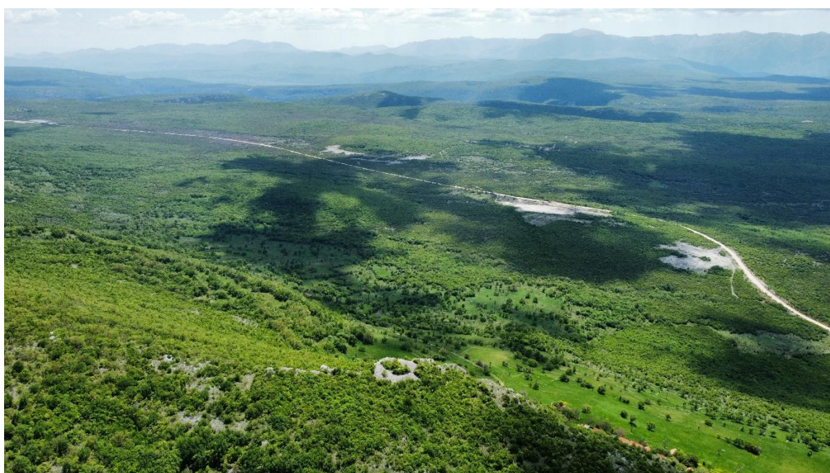
Slika 113 Pogled na zonu izgradnje
