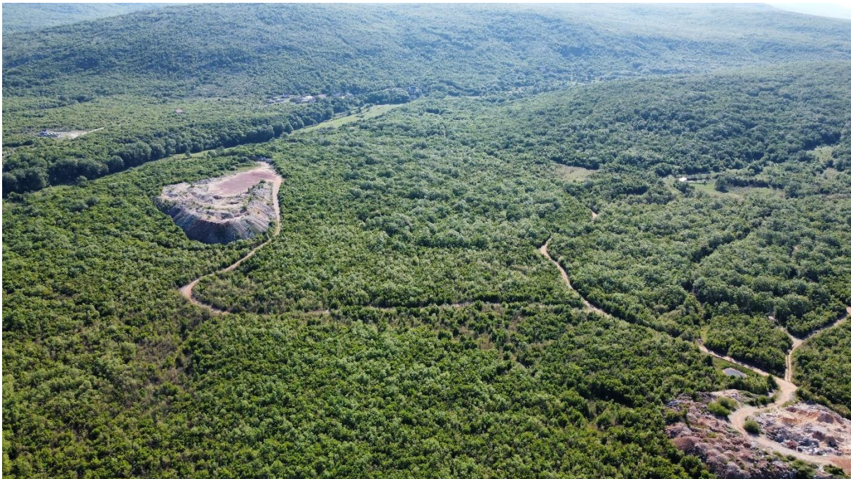
Slika 119 Pogled na zonu izgradnje
