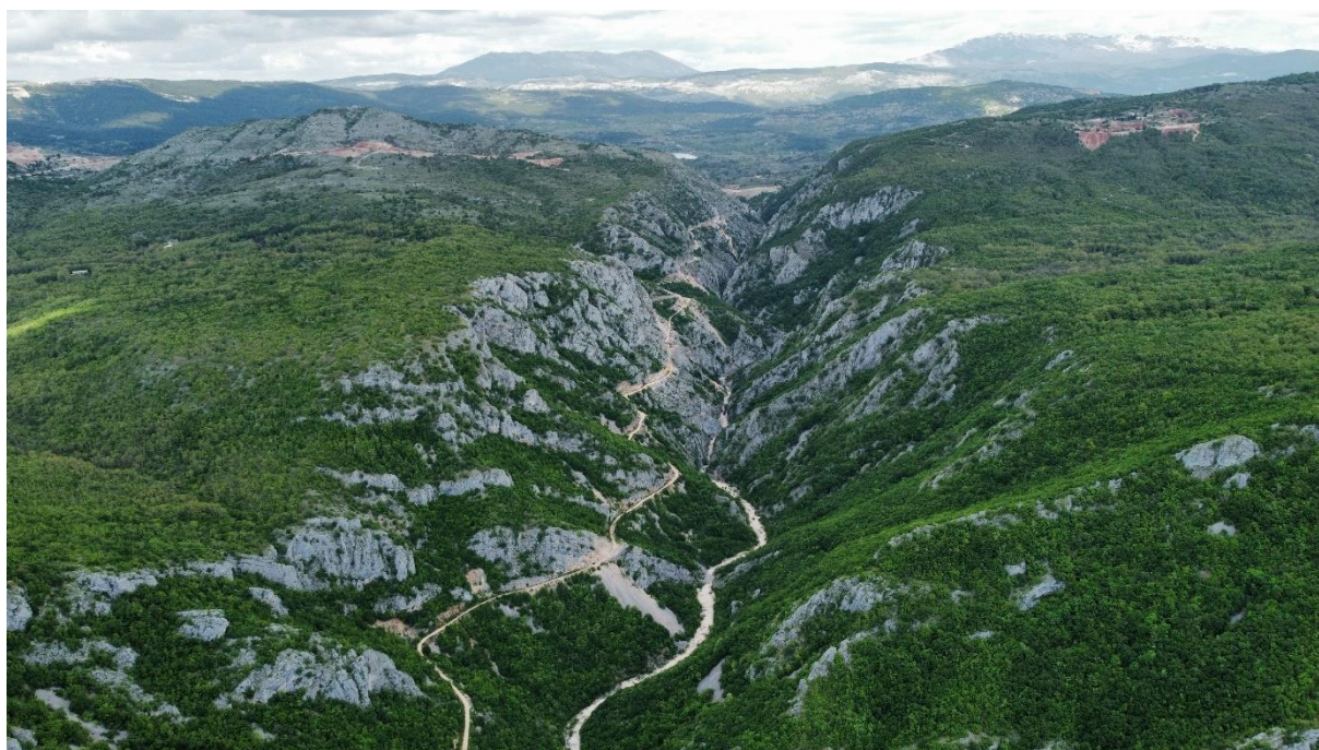
Slika 124 Pogled na zonu izgradnje
