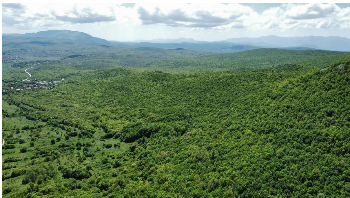
Slika 103 Pogled na zonu izgradnje
