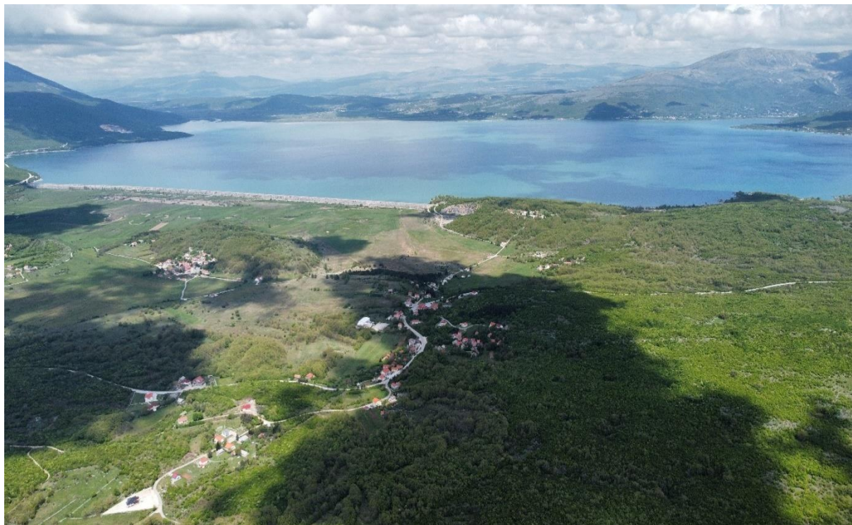
Slika 106 Pogled na zonu izgradnje
