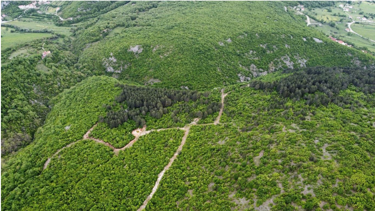
Slika 118 Pogled na zonu izgradnje
