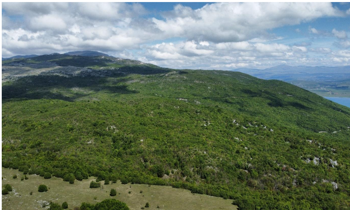
Slika 99 Pogled na zonu izgradnje
