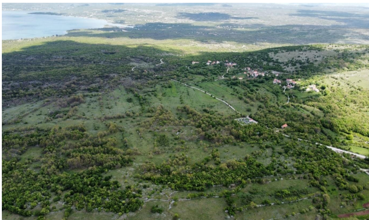
Slika 108 Pogled na zonu izgradnje
