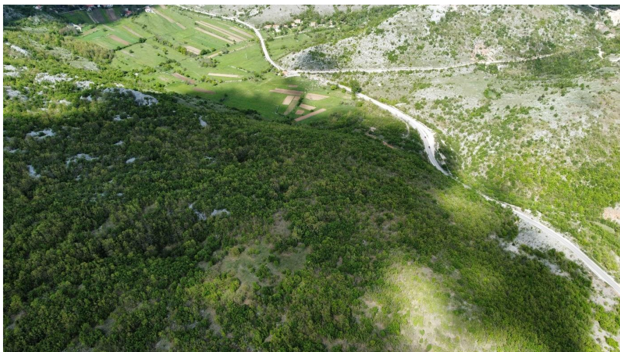
Slika 128 Pogled na zonu izgradnje
