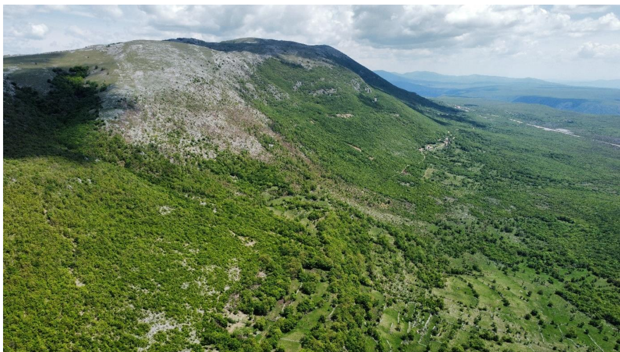
Slika 114 Pogled na zonu izgradnje
