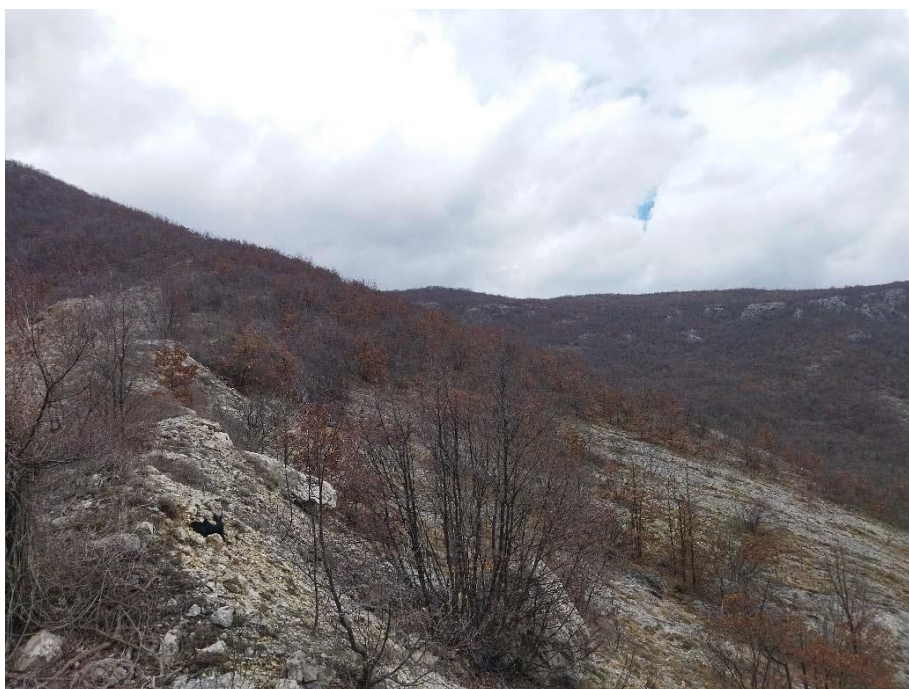
Slika 67 Pogled na lokaciju stupa 50
