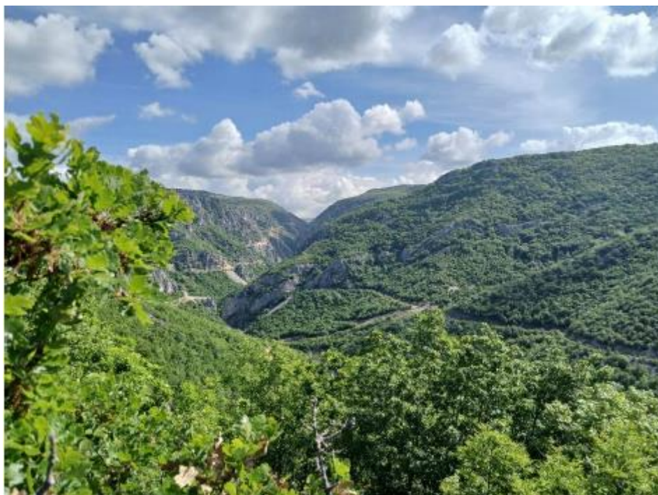
Slika 73 Pogled preko kanjona rijeke Ričine, sa stupnog mjesta 119, na stupno mjesto 120
