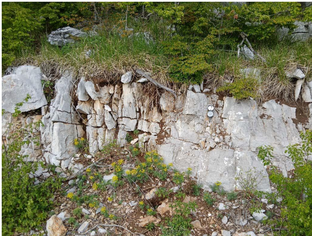
Slika 61 Zasjeak pristupne ceste u neposrednoj lokaciji bušotine B-1
