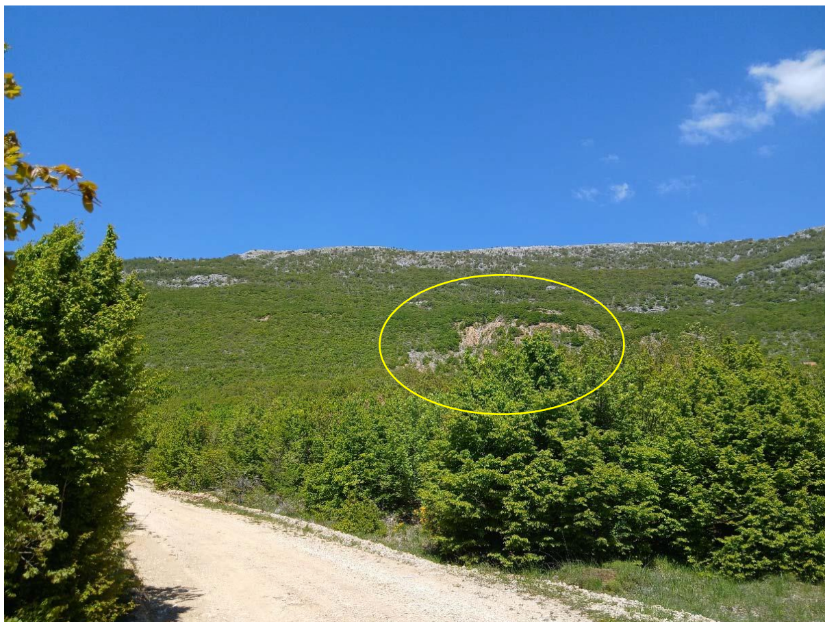
Slika 52 Vidljivi nekoherentni i osulinski materijali duž navlake podno Zavelima (stupovi 65 – 66)
