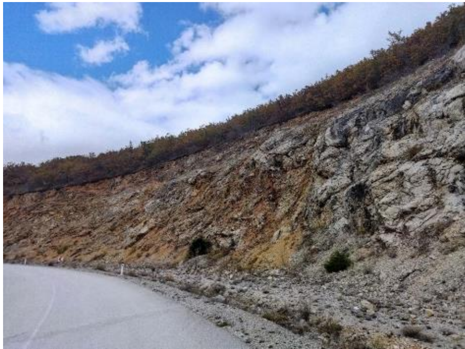
Slika 68 Tektonski kontakt između dva inženjerskogeološka bloka, IG blok 6 (lijevo) i IG blok 7 (desno)
