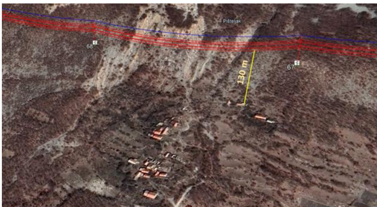
Slika 33 Udaljenost trase dalekovoda od najbližeg stambenog objekta u zaseoku Paljike u naselju Zavelim
