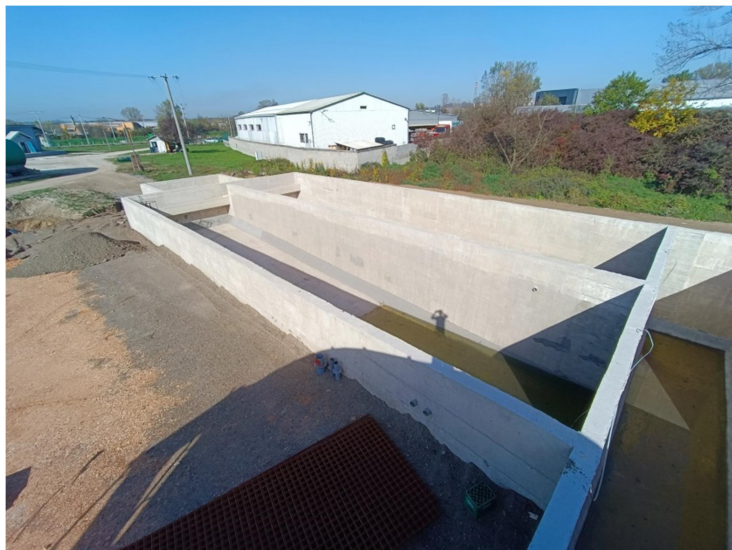
Slika 4.: Radovi na izgradnji postrojenja za prečiščavanje otpadnih voda sa filter stanice
