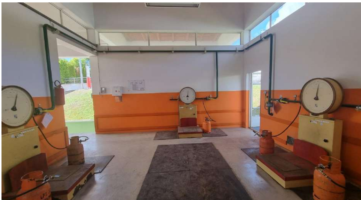
Slika 14. Unutrašnjost objekta punionice
