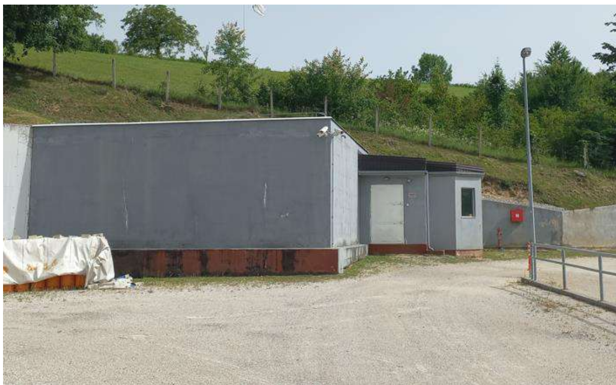
Slika 7. Hidrantska stanica i agregatska stanica
