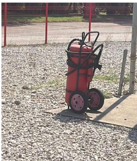
Slika 12 Aparat punjenja 50 kg praha – pokraj spremnika UNP-a
