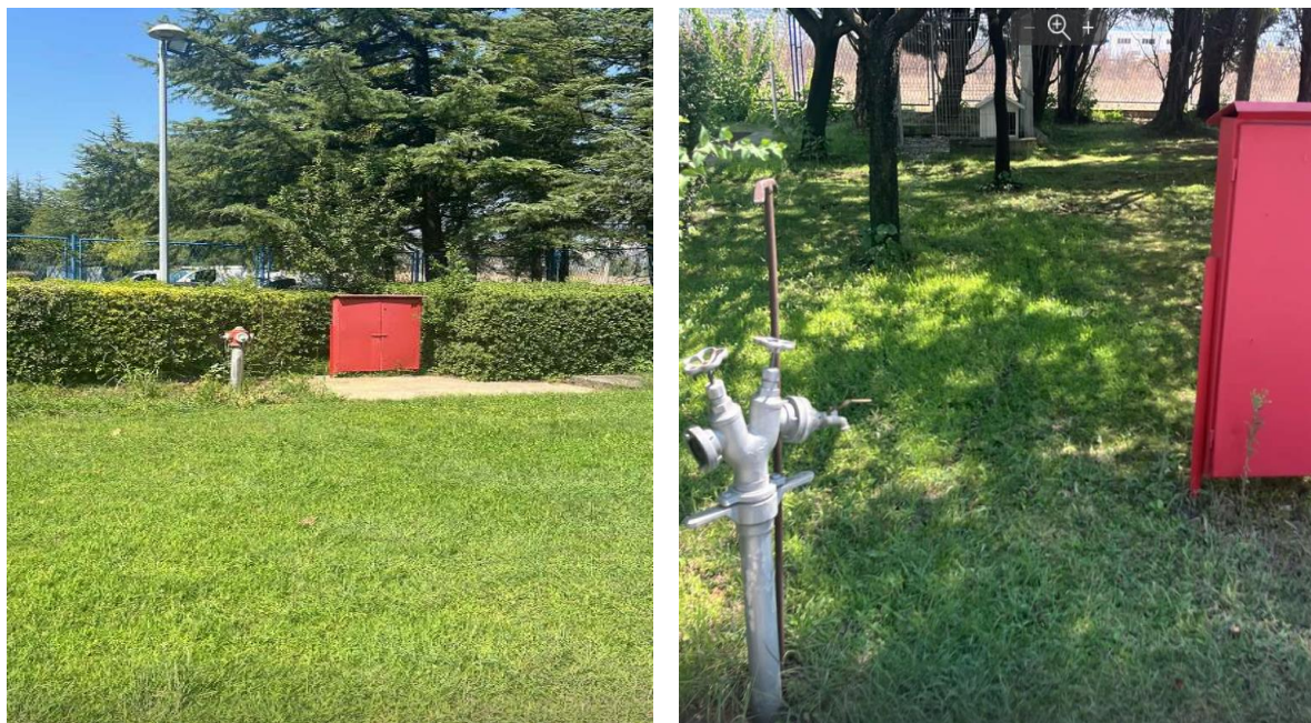
Slika 11 Prikaz izvedbe vanjske hidrantske mreže
