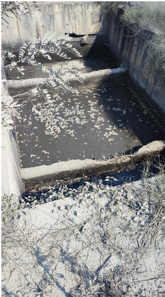
Taložnik oborinskih i površinskih voda na lokaciji pogona Krečna peć
