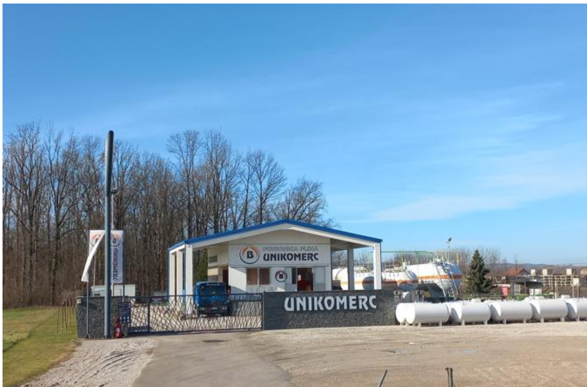
Slika 10. Postrojenje za pretakanje, skladištenje i distribuciju ukapljenog naftnog plina (UNP) operatora UNIKOMERC d.o.o. Gradačac
