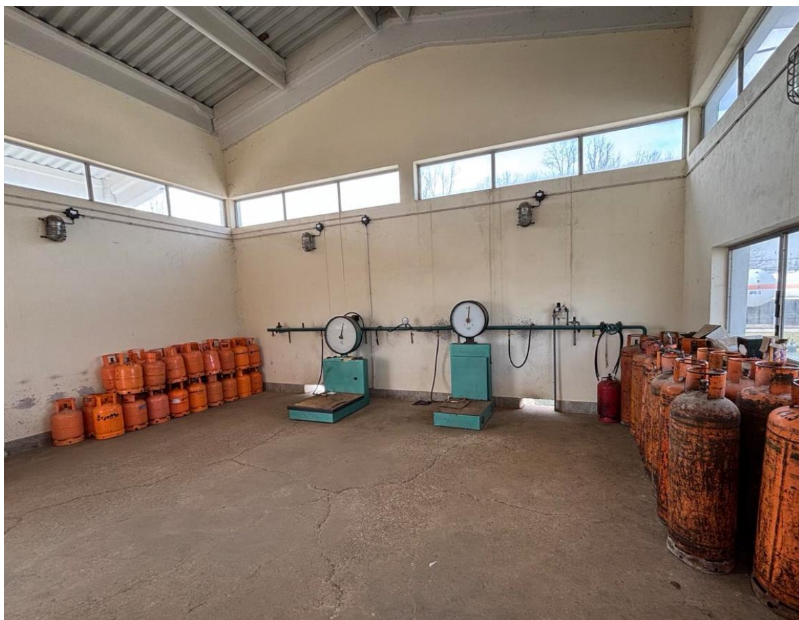
Slika 12. Unutrašnjost objekta punionice
