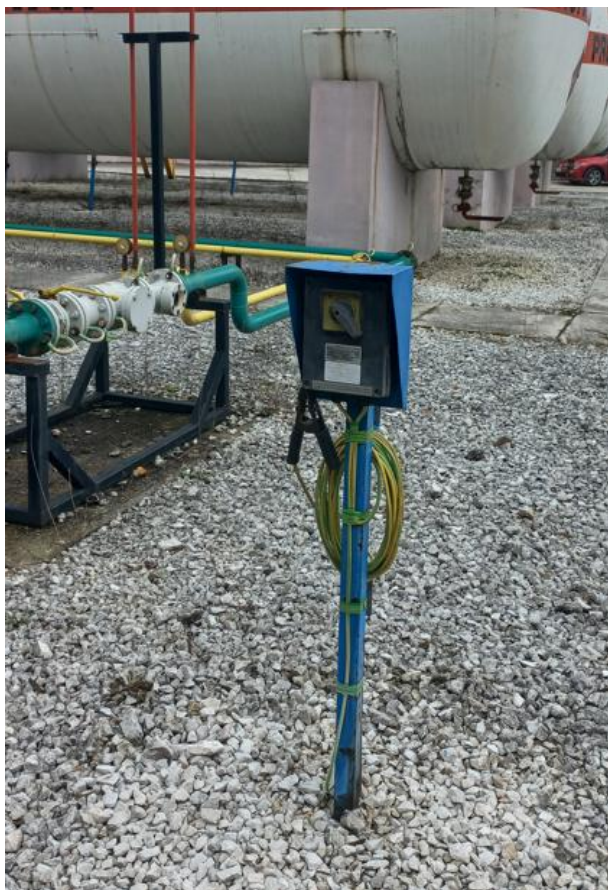
Slika 19. Sistem za uzemljenje, mjerno-regulaciona oprema, sistem za hlađenje rezervoara
