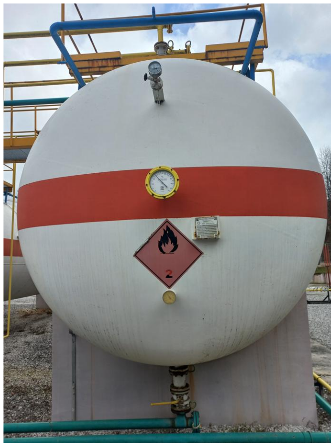
Slika 19. Sistem za uzemljenje, mjerno-regulaciona oprema, sistem za hlađenje rezervoara
