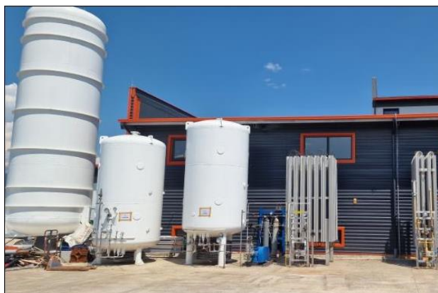
SLIKA 19: REZERVOARI TEHNIČKIH PLINOVA
