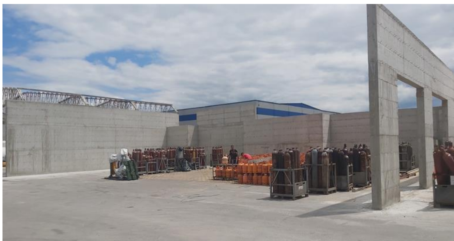
SLIKA 20: SKLADIŠTE PUNIH I PRAZNIH BOCA-NADSTREŠNICA (U IZGRADNJI)
