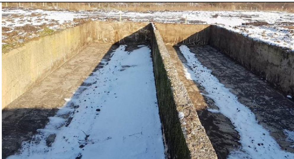
Slika 16. Armirano-betonske lagune za skladištenje đubreta
