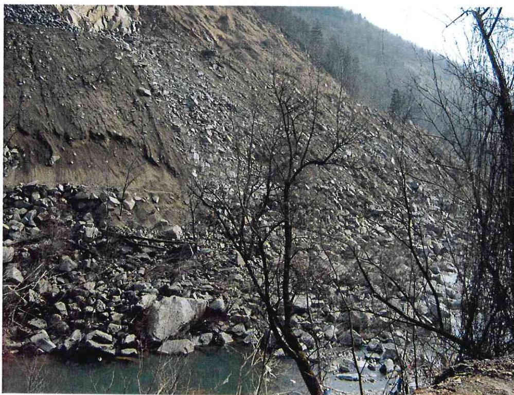
Slika A1.6. Nožica odlagališta otpadne stijenske mase na reviru „Ploče“ površinskog kopa „Car“ u koritu rijeke Neretve
