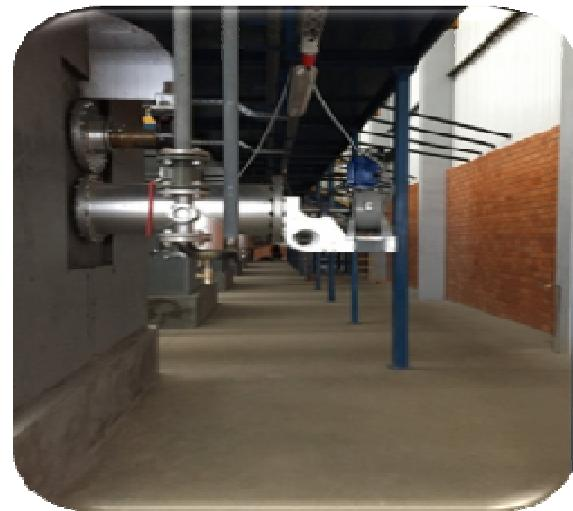
Slika 14. Reaktori za pirolizu gume (uz reaktor instalirane su komore za uklanjanje prašine)
