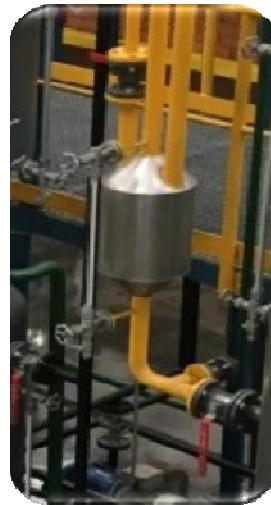
Slika 22. Protupožarni „Back-fire“ uređaj
