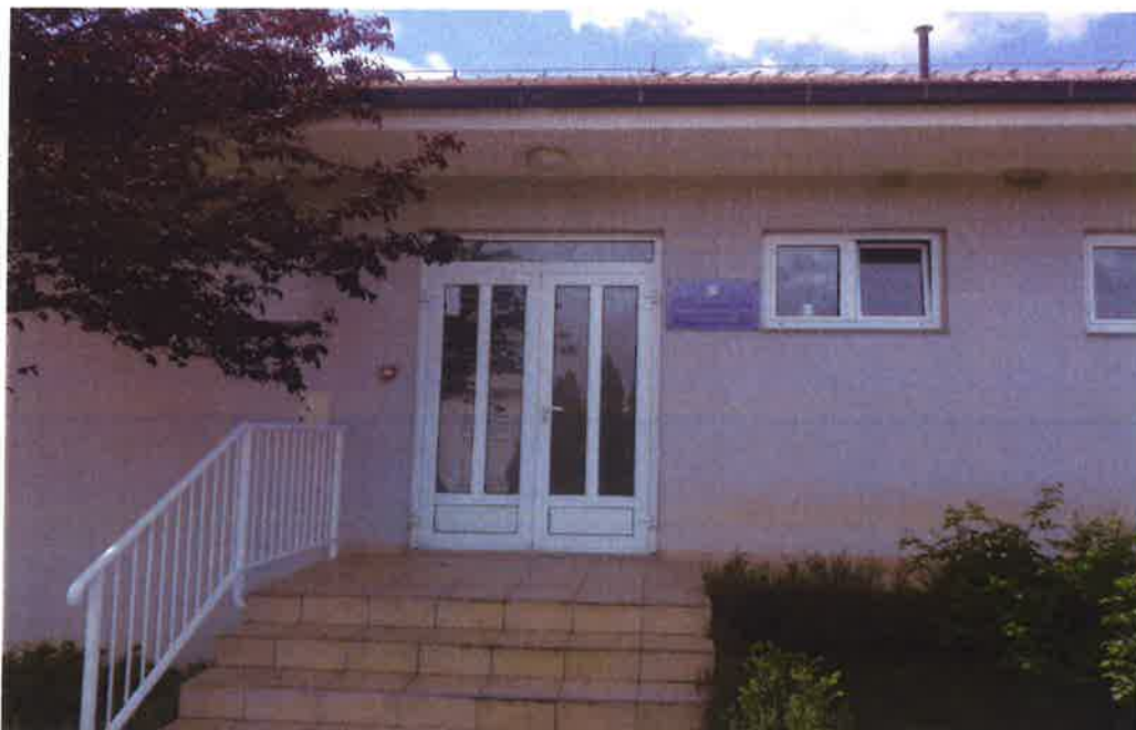
Slika 15 Upravljački objekt sa kompresornicom u podrumu
