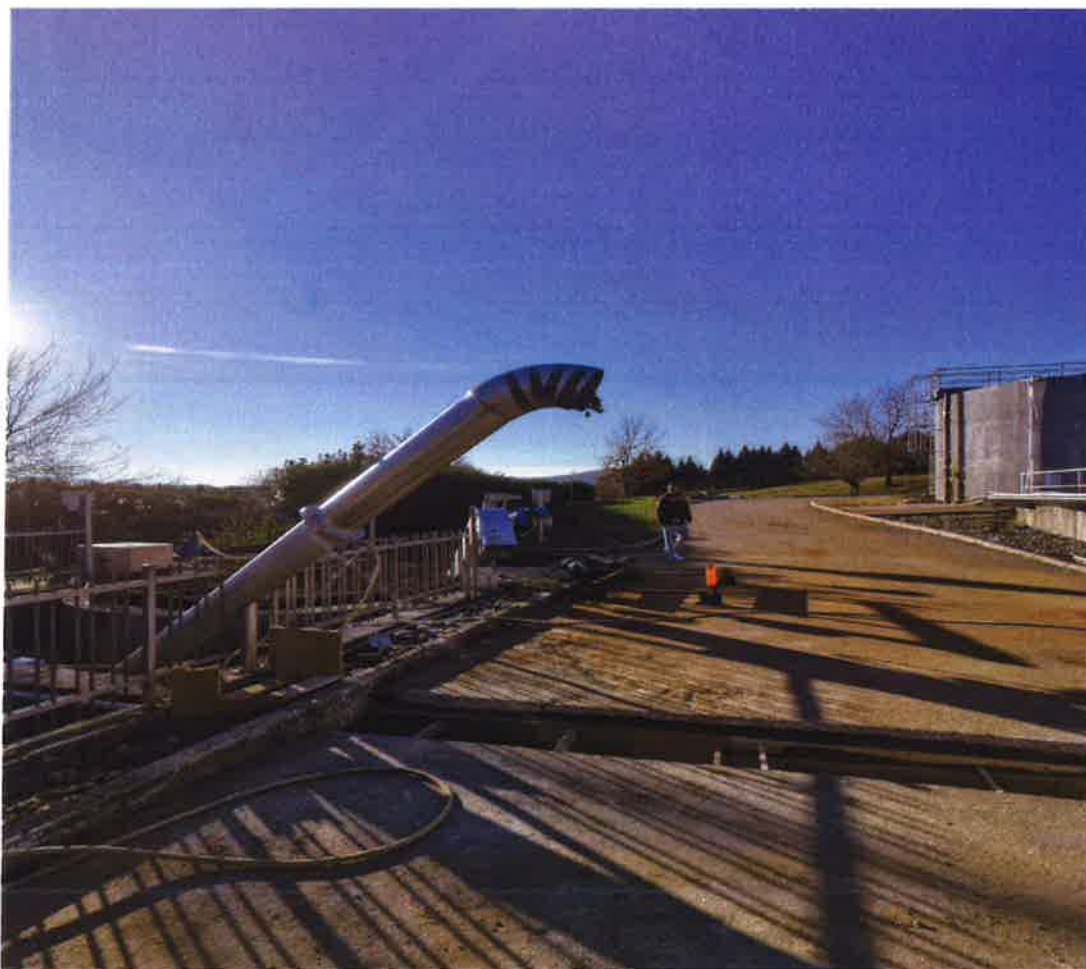
Slika 19 Proces mehaničkog čišćenja - Sito (odvajač krupnih čestica)
