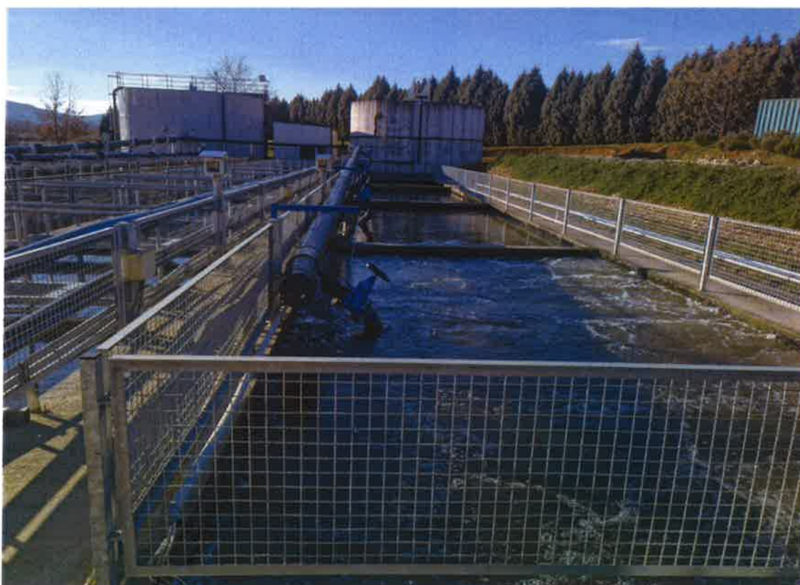
Slika 26 Bioaeracijski bazeni 2 x 4 polja i taložnik mulja 2 x 12 polja
