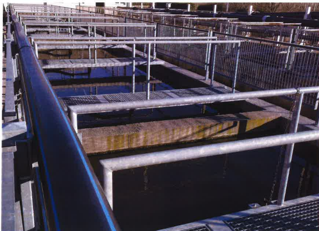
Slika 25 Bioaeracijski bazeni 2 x 4 polja i taložnik mulja 2 x 12 polja
