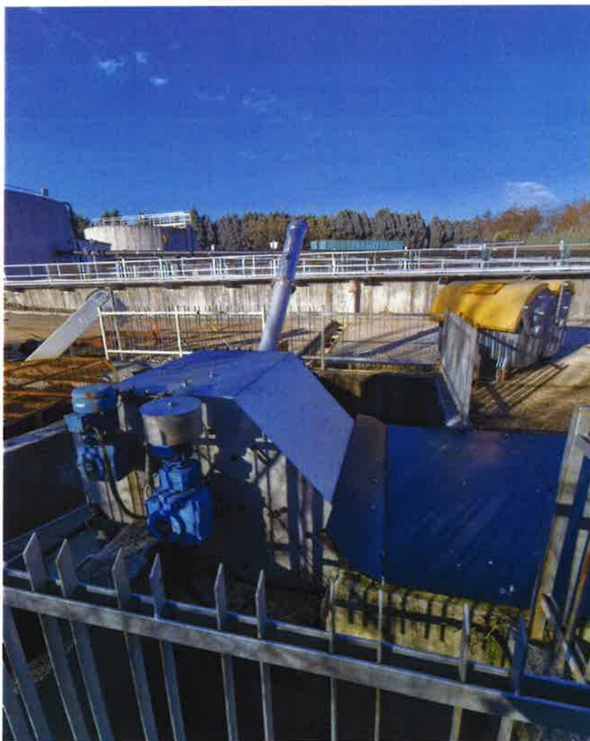
Slika 18 Proces mehaničkog čišćenja - Sito (odvajač krupnih čestica)
