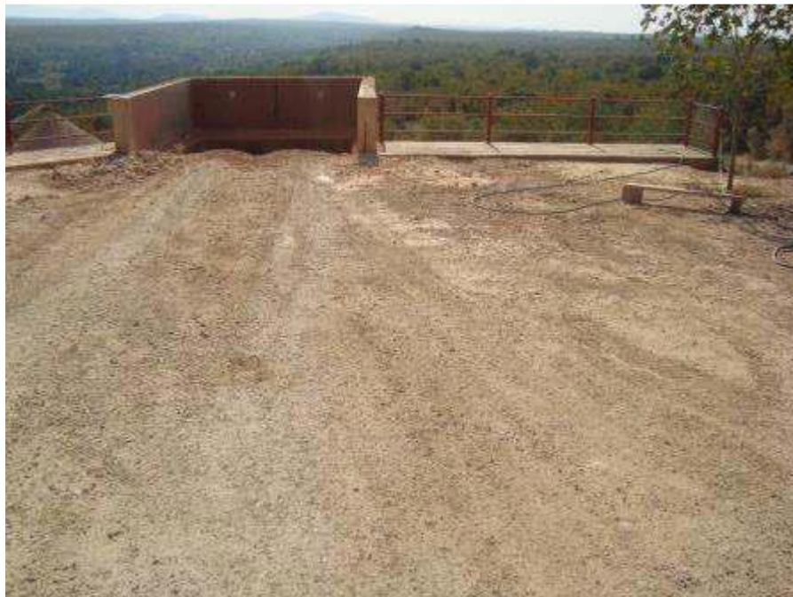
Slika 4.13. Prihvatni koš primarno drobilnog postrojenja
