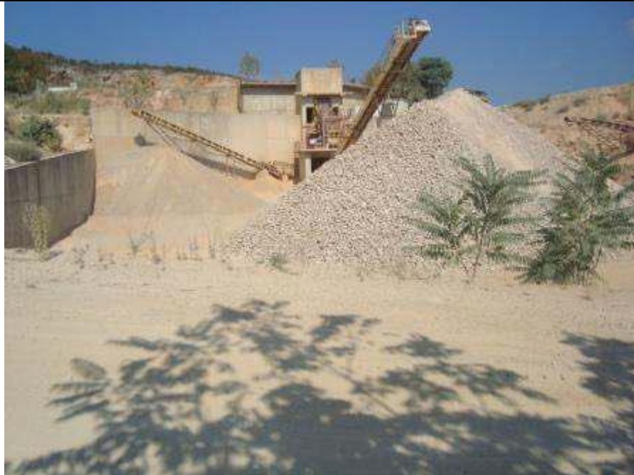
Slika 4.12. Primarno drobilno postrojenje
