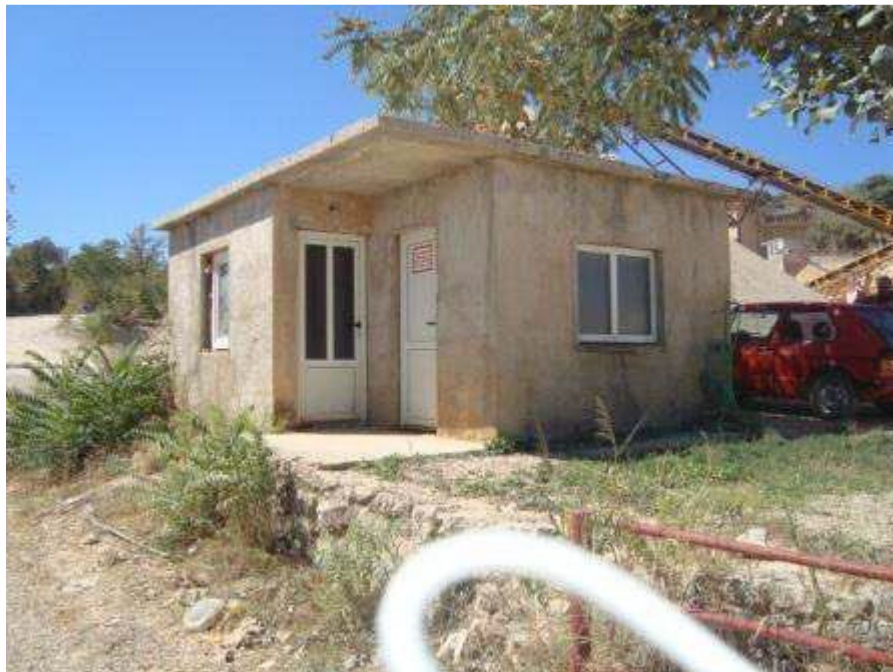
Slika 4.21. Potporni zidovi kod PUD
