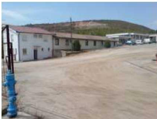
Slika 4.19. Upravna zgrada i skladište
