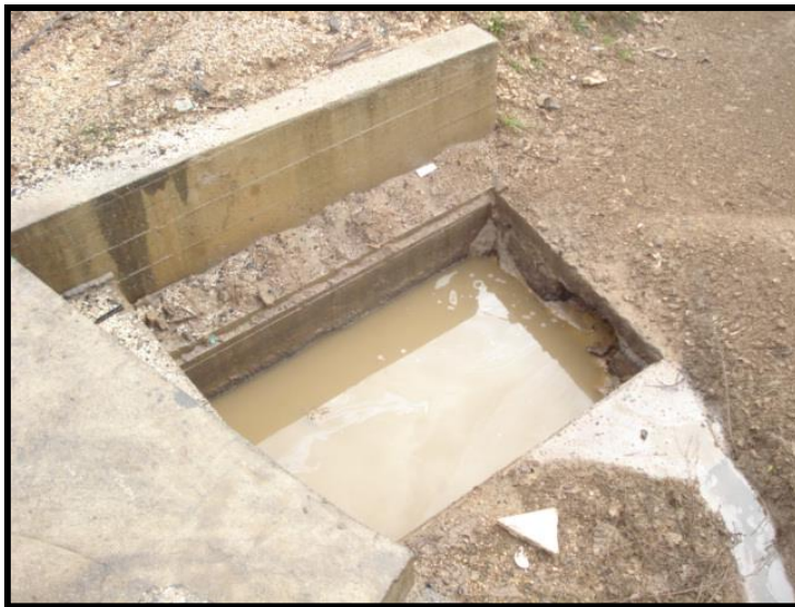
Slika 6.1. Seperator otpadnih voda
