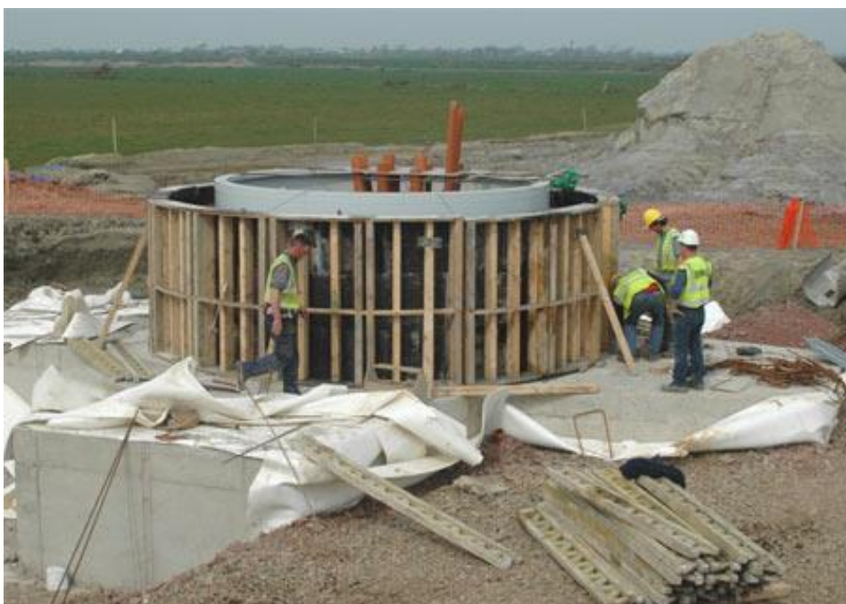
Slika 5. Uobičajeno temeljenje vjetroturbine
