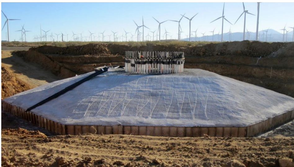
Slika 4. Ogladni primjer temelja vjetroturbine
