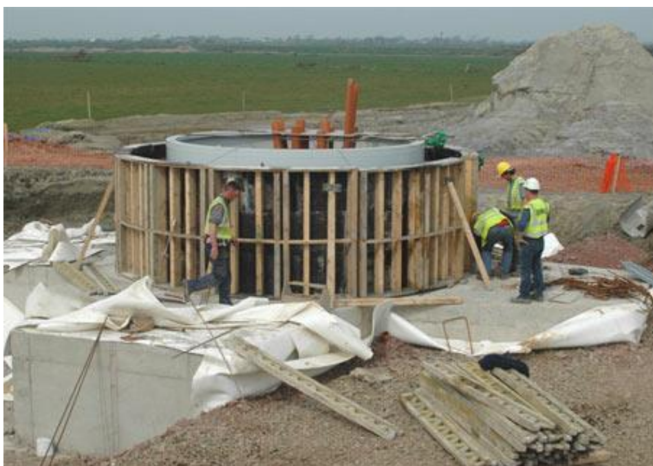
Slika 6. Uobičajeno temeljenje vjetroturbine
