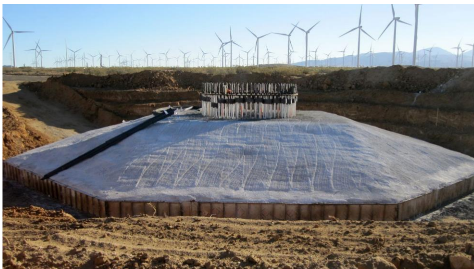
Slika 5. Ogledni primjer temelja vjetroturbine
