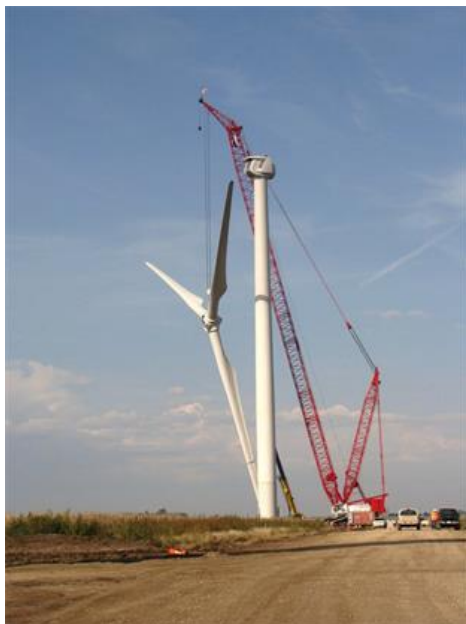
Slika 7. Sklapanje vjetroturbina
