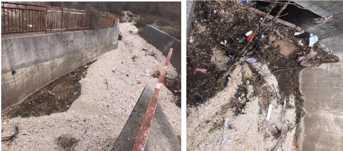
Slika 19. Stanje korita potoka Sušice - lokacija ulazne građevine
