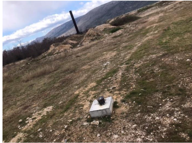
Slika 21. Novi pijezometar na lokaciji iznad (istočno) stare deponije pored AB ograde
