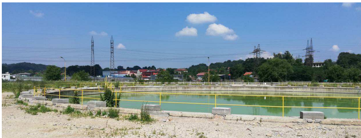
Slika 18. Bazen za prikupljanje otpadnih voda sa deponije Jezero (reciklacija)
