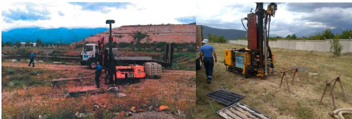
Slika 11. Izvođenje bušotina i ugrađivanje pijezometara na lokaciji između dvije plohe za odlaganje (B2) i pored ograde na istočnoj lokaciji izvan uticaja - B1 (07.08.2020. godine)
