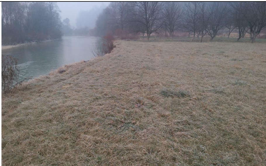
Slika 6: Pogled uzvodno od mjesta gradnje MHE "Obarnica"
