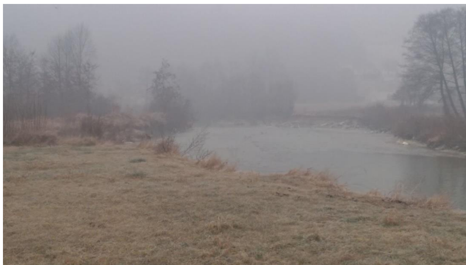
Slika 8: Pogled nizvodno od mjesta gradnje MHE "Obarnica"
