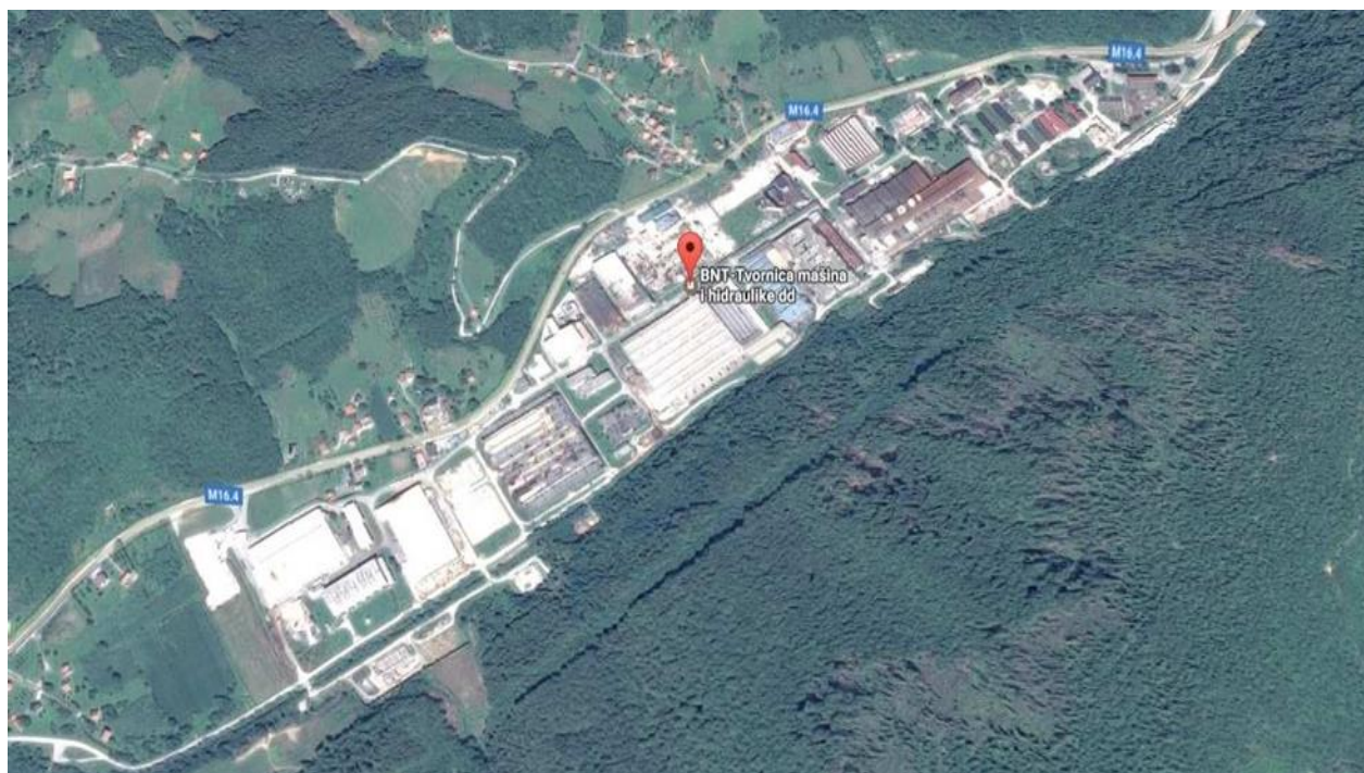
Slika 1 Satelitski snimak mikrolokcije objekta BNT – Tvornice mašina i hidraulike d.d. Novi Travnik
