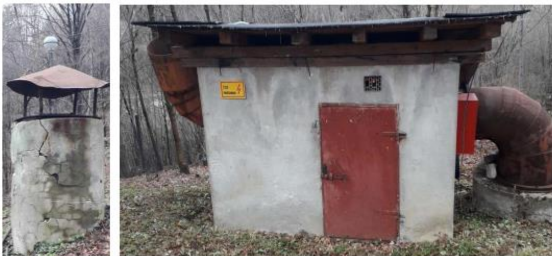
Slika 14. Ulazno ventilaciono okno i ventilaciono postrojenje na površini
