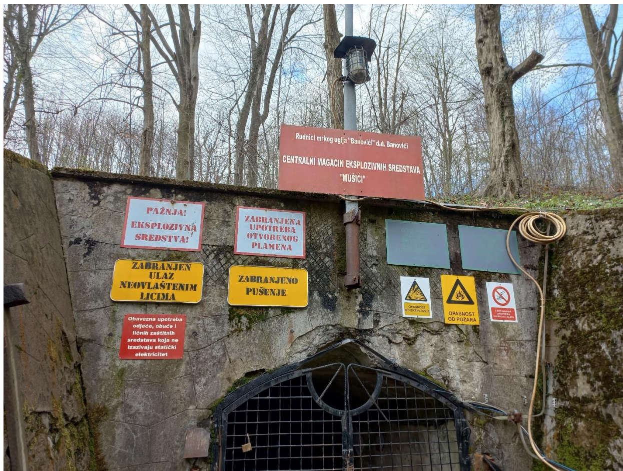
Slika 15. Znakovi postavljeni na ulazu u centralni magacin eksplozivnih sredstava „Mušići“
